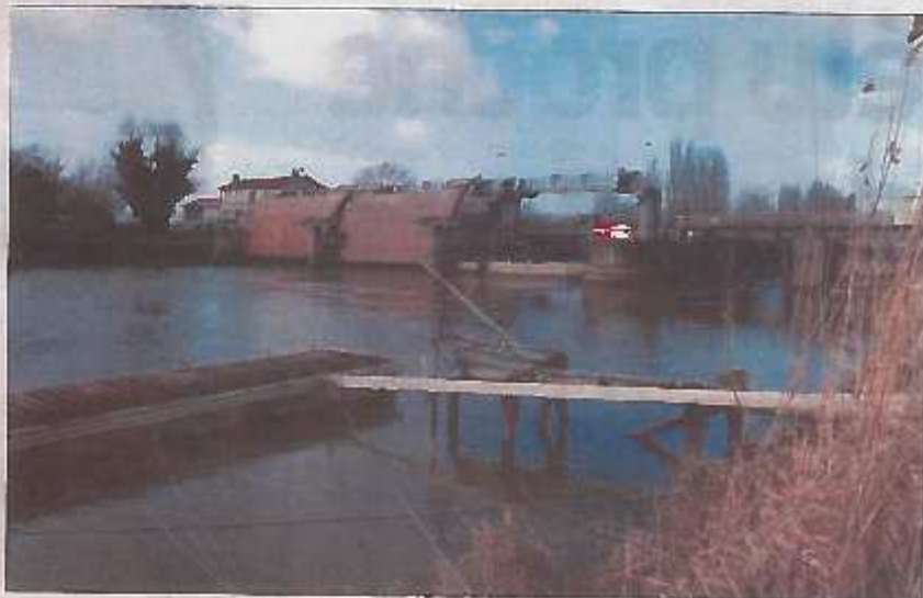
L'un des barrages de Saint-Savinien. PHOTO: ARD OUEST
