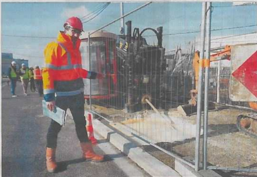
Alexandre Favrel, cadre de la société Gendry, montre la foreuse utilisée près de la BA 709. Avec cette machine, il est possible de poser des réseaux sans creuser de tranchée. P. CROCI S.
