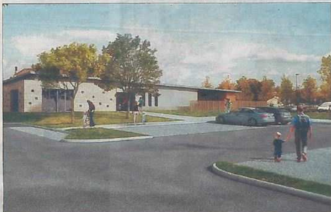
L'établissement de 730 m 2 de locaux pourra accueillir 70 enfants, avec une possibilité d'extension future à 100.
