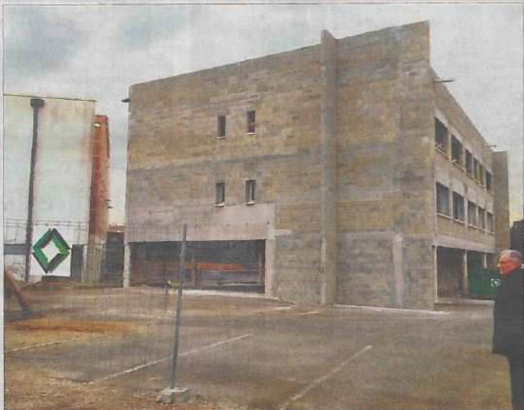
Le nouveau bâtiment sera relié à l'ancien par deux passerelles. La livraison est prévue pour l'été prochain.
