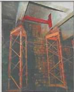
Les étais sont en place depuis 1999.
